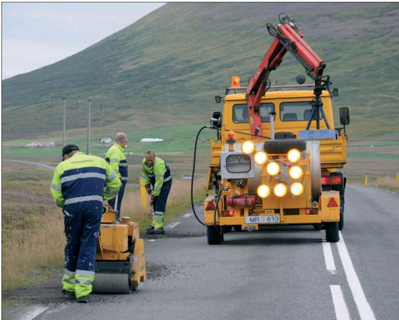
Starfsmenn Vegagerðarinnar á Húsavík í slitlagaviðgerðum á Hringvegi (1) austan Ljósavatns.
